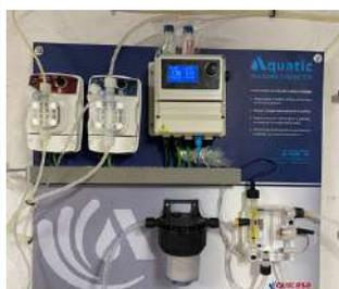
Se ha instalado un nuevo panel de control de PH y Cloro Libre para el mantenimiento del agua. Esta inversión ha sido de 4.219,10€ pagado por el Ayuntamiento.
