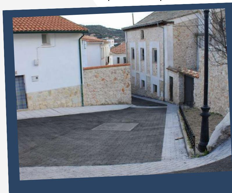
llevado especialmente en el tramo de las escaleras, donde se han instalado barandillas perimetrales y centrales. Precisamente en ese punto, se han reparado los escalones, levantado nuevos bordillos de piedra natural y se ha ajardinado el espacio. Además, junto con los 445 m<sup>2</sup> asfaltados, también se ha creado una acera de durogranito y se han soterrado las bajantes de aguas pluviales de las viviendas colindantes para conectarlas con la red de saneamiento local.
