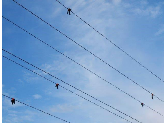
Tendido eléctrico anti choques
