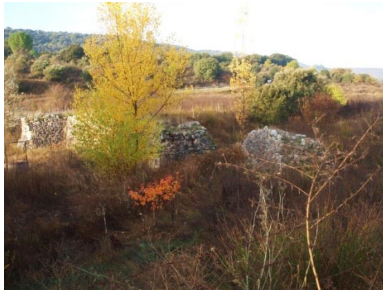
Presa del Paredón (ruinas)
