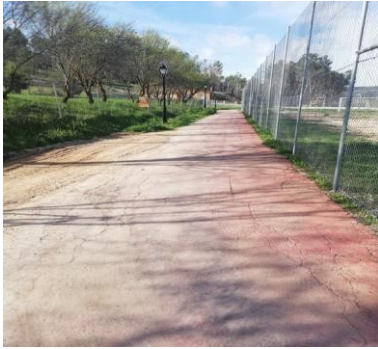
Vía Verde (Lateral Este.)
