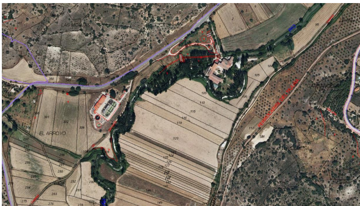
Figura 142. Ubicación de la EDAR conjunta de Ambite
